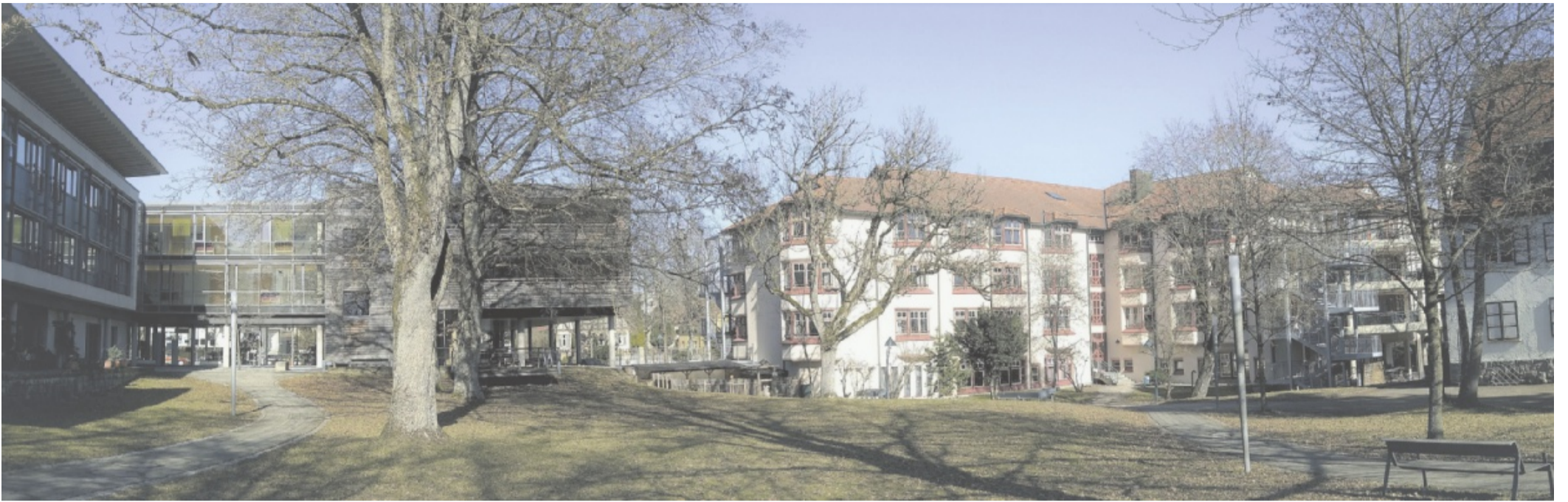
Eine großzügige Parkanlage steht den Bewohnern des Bürgerheimes an der Mauthestraße in Schwenningen zur Verfügung. Das Heim mit jetzt insgesamt 133 Plätzen besteht aus dem Haus „Schwenninger Moos“ (links) und dem Haus „Neckar“ (rechts). Fotos: Jochen Schwillo
