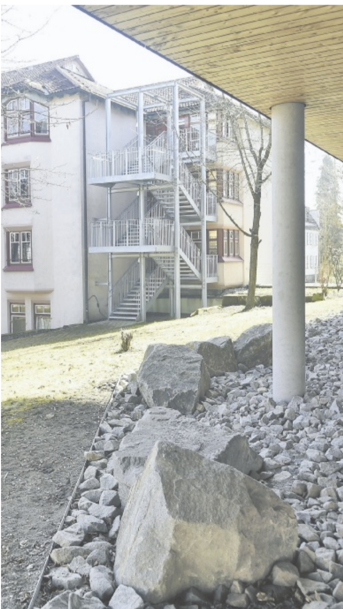
Insgesamt drei neue Fluchttreppenhäuser wurden an das Haus „Neckar“ angebaut.
